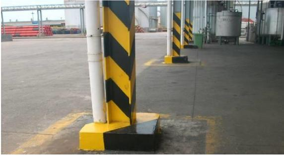
⑤黄黑斑马线：警告、警示（地面突起物、易碰撞处、坑道、台阶等）；
